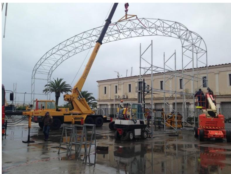
Figura 24 - Fase di montaggio della struttura metallica
